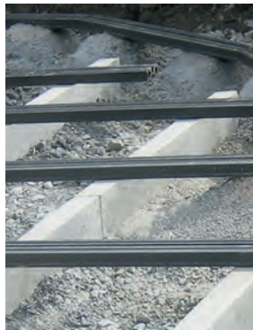
Montage auf Randsteinen
